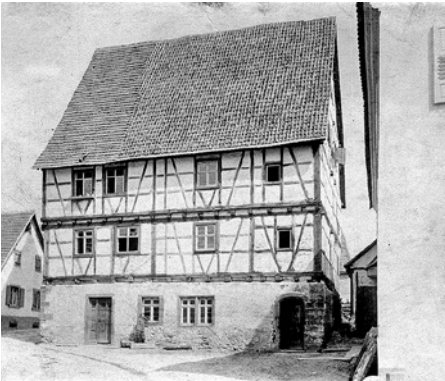
© Landesamt für Denkmalpflege Dienstsitz Karlsruhe
