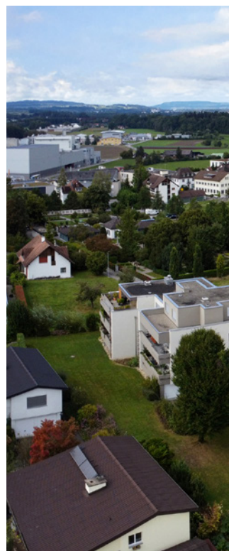
Relining der TPS AG Abwasserkanalsanierung in Aarburg
